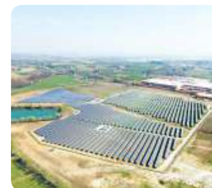
Uno degli impianti sviluppati da Renergetica
